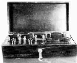
CONNECTICUT TEL. & ELEC. SODION NON-REGEN. DET. 2 STAGE AUDIO
