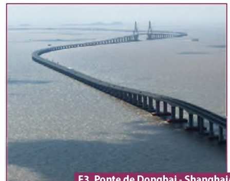
F3. Ponte de Donghai - Shanghai/ Yangshan, China.
