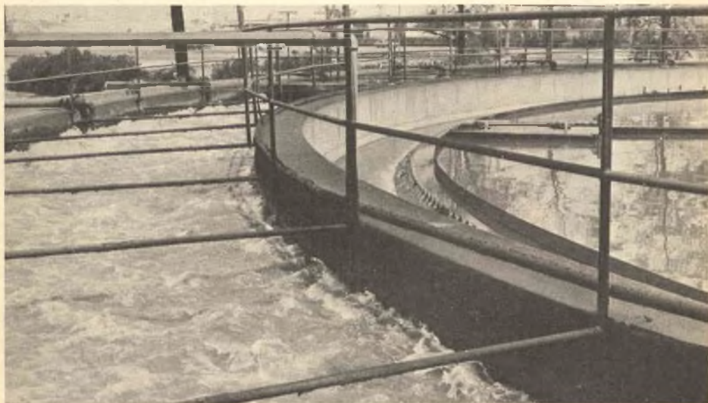
Fig. 1 - Sistema di schiumatura ed aerazione in un impianto per il trattamento dell'acqua.
