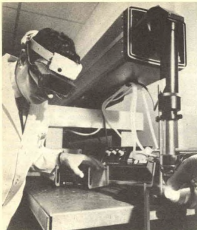
Un tubo di quarzo viene tagliato con un laser al biossido di carbonio prodotto dalla Sylvania.
