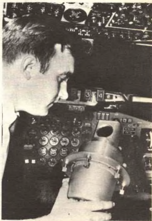
Testata sensibile del sistema infrarosso della Barnes, per localizzare i CAT, montata nella carlinga di un Boeing 707 della Pan American.
