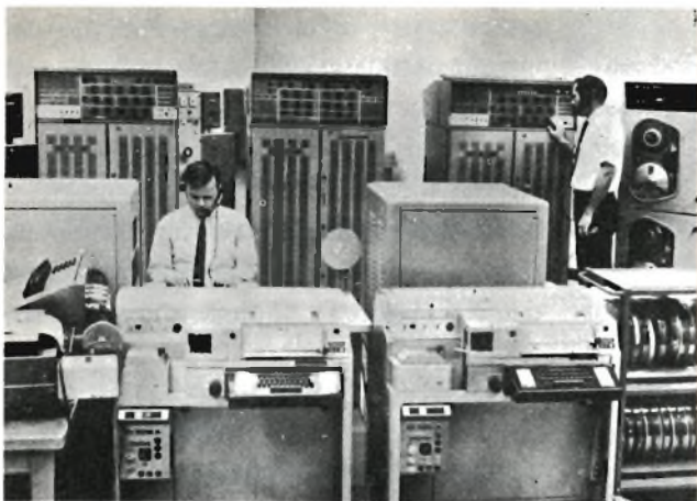
Fig. 3 - Elaboratori UNIVAC 494 installati presso il Centro di volo spaziale Goddard. Gli orologi in alto mostrano l'ora delle varie stazioni che trasmettono i dati.
