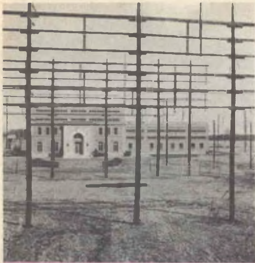
Le antenne rombiche dirigono le chiamate dal New Jersey verso Europa, Africa e Sud America.
