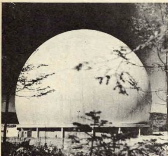
Ecco l'aspetto dell'antenna a tromba ormai ultimata, e protetta dalla copertura definitiva.
