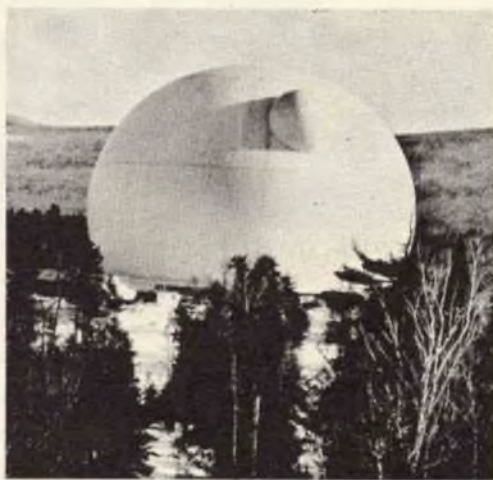
Nella fotografia si vede la copertura provvisoria piazzata durante la costruzione dell'antenna.
