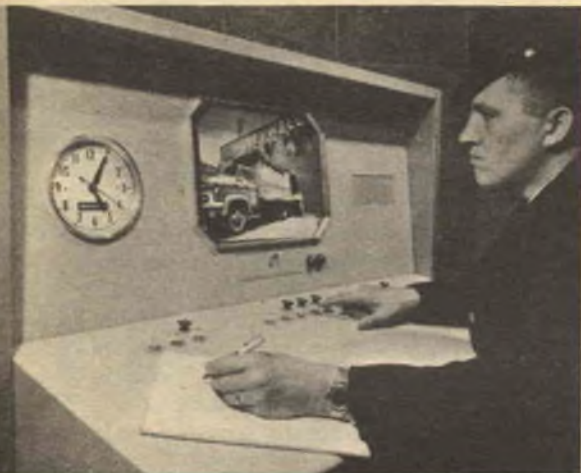
Apparecchi televisivi o macchine di ripresa cinematografica sono spesso inclusi in sistemi d'allarme anti-furto. La televisione offre una veduta istantanea su un monitor, mentre la registrazione su film può essere molto utile ai fini dell'identificazione e come prova.
