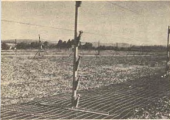
Fogli di plastica sotto il recinto a capacità impediscono la crescita di erbacce che potrebbero causare falsi allarmi. In aree ristrette si usano fili volanti per rivelare l'approssimarsi di una persona da entrambi i lati.
