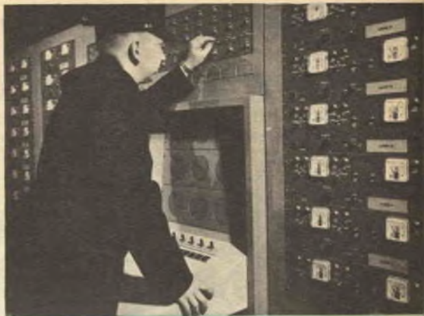
Impianti centralizzati di controllo in molti grandi stabilimenti permettono a una sola guardia di sorvegliare luoghi distanti. I segnali provenienti da ogni tipo di rivelatore possono essere collegati ad un solo pannello.
