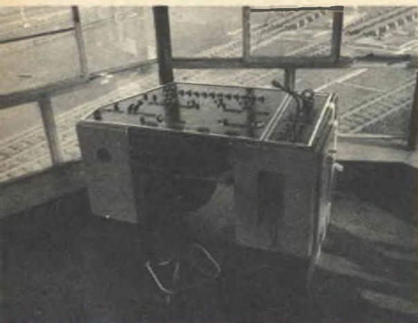
Il Tempio Mill Yard è quasi completamente automatizzato ed il movimento dei carri è regolato con l'aiuto del radar. Dalla torre di controllo, alta quasi 11 m, è possibile sorvegliare tutto il piazzale e comandare il movimento per mezzo di due quadri di controllo, uno dei quali è visibile nella fotografia riprodotta.
