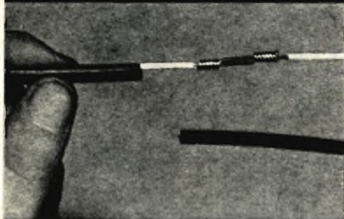
Fig. 1 - L'isolamento della saldatura si effettua in due tempi. Prima si introduce nel conduttore un tubetto di gomma e poi si effettua la saldatura. In un secondo tempo si ricopre la saldatura col tubetto e mediante un fiammifero si provoca la fusione delle sue estremità.
