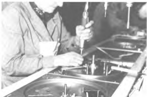
Linea di montaggio della piastra giradischi L 78
