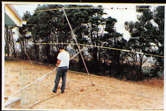
Montage d'une antenne avant le trafic.
