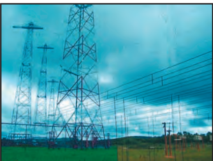
5 - Antennes rideaux de Radio Nederland (en bas à gauche, ligne symétriques 300 ohms)
