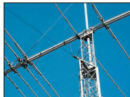
Figure 4: La fixation au sommet du pylône.
