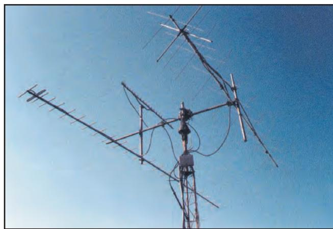
Figure 7 : Antennes type Yagi de FHDD.
