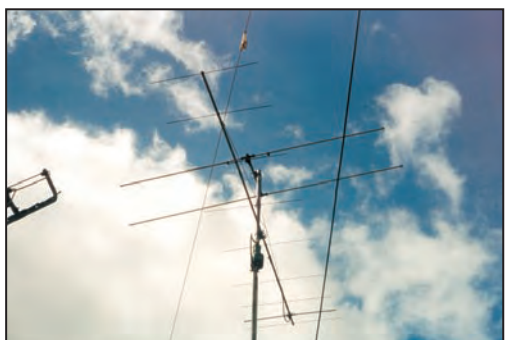
Les antennes de CN2DX à Casa.
