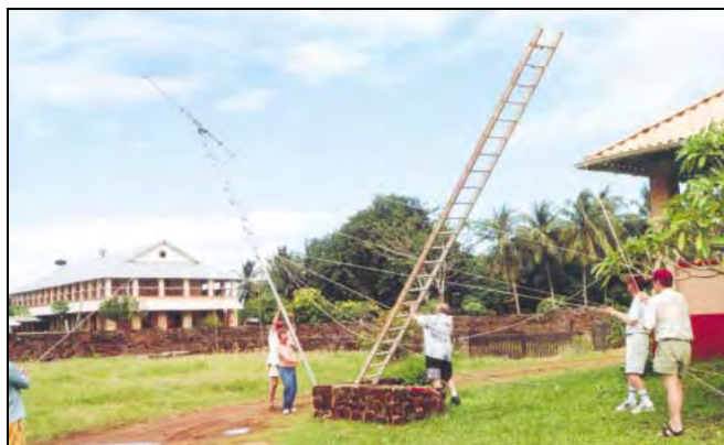
Comment démonter des aériens 50 MHz.
