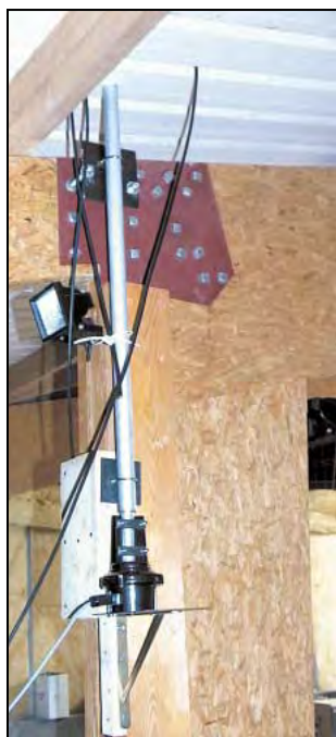
Le montage du rotor à l'intérieur du bâtiment.
