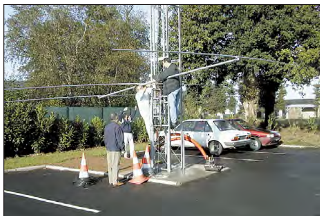
Montage d'une 3 éléments 18 MHz.
