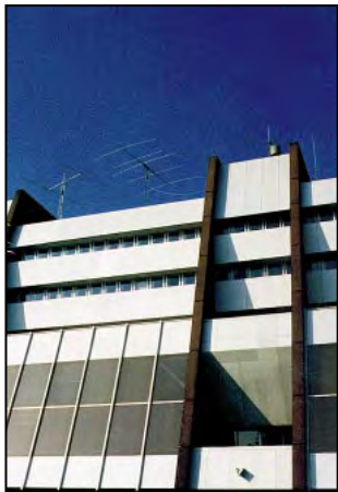
A gauche : 2 élém. beam 40m. Au centre : 5 élém. beam 10-15-20m. A droite : 3 élém. beam WARC.
