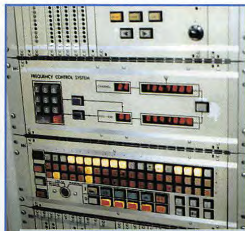
Centre émetteur de Wavre. Pour régler la fréquence...
