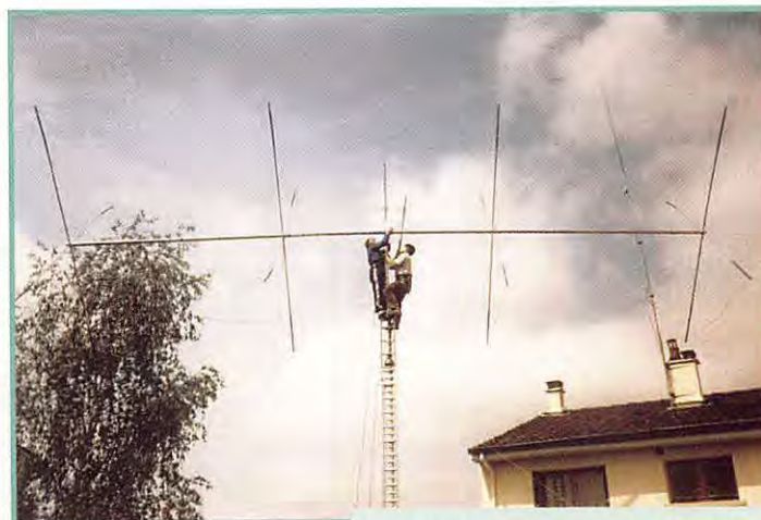
4 éléments quad 21 MHz. Antenne F6DPR, F6DDR.
