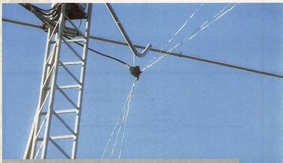
Fixation du multi-dipôle sur un mât.
