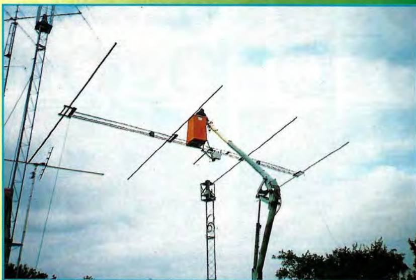
Montage de la poutre, F1NZK aux commandes
