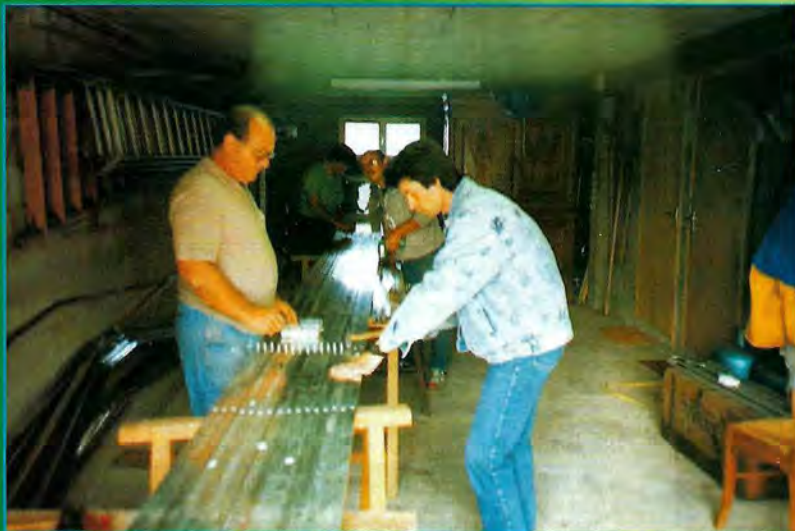
Construction de l'antenne avec F1NZK et F5GHP.
