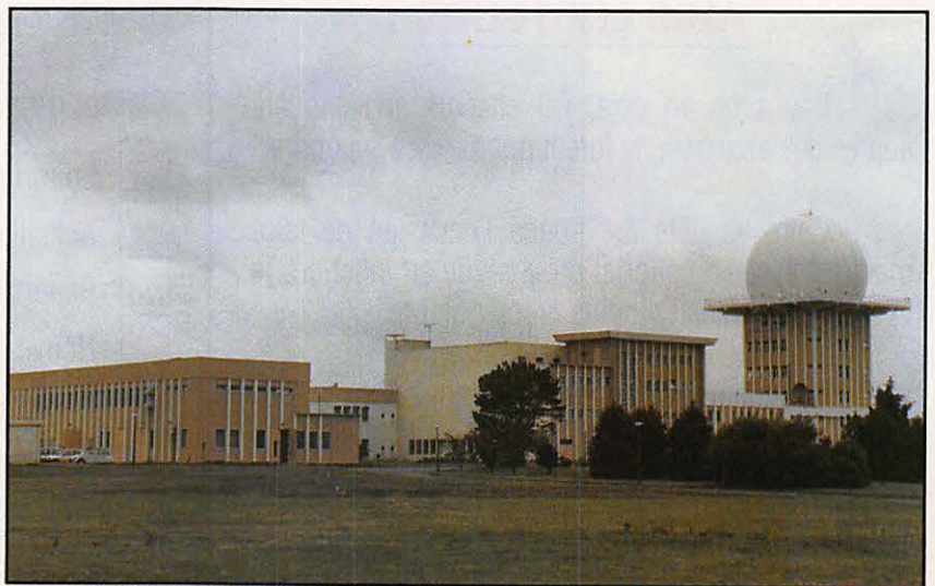
Les bâtiments du CRNA Ouest.
