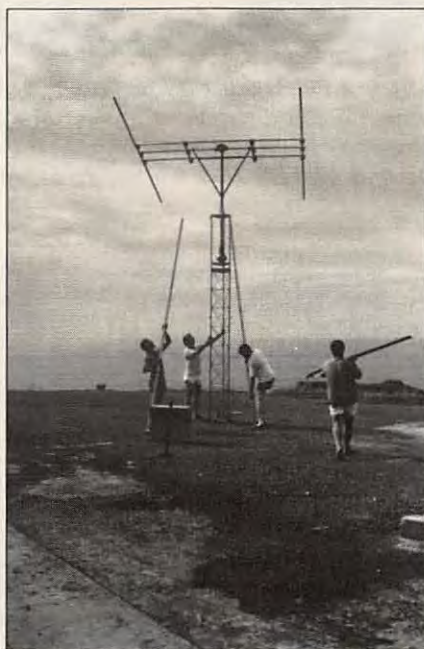
Montage de la structure support d'antennes.
