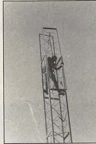
Montage d'un panneau.
