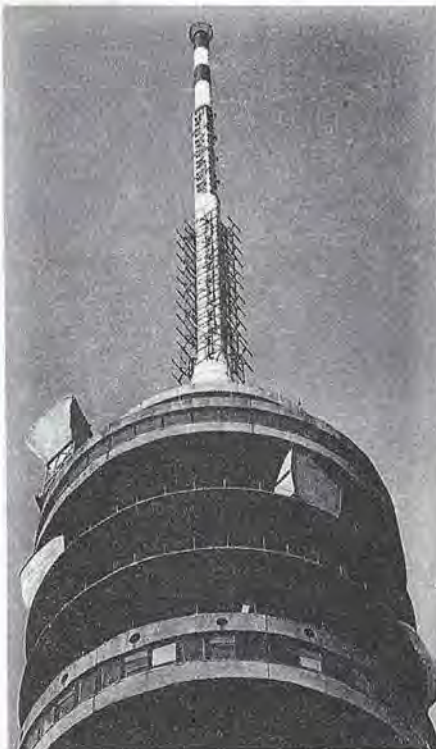
Tour de faisceaux hertziens surmontée du pylône supportant les antennes émettrices FM et TV du centre de GOES. Au premier plan, la salle d'exploitation.
