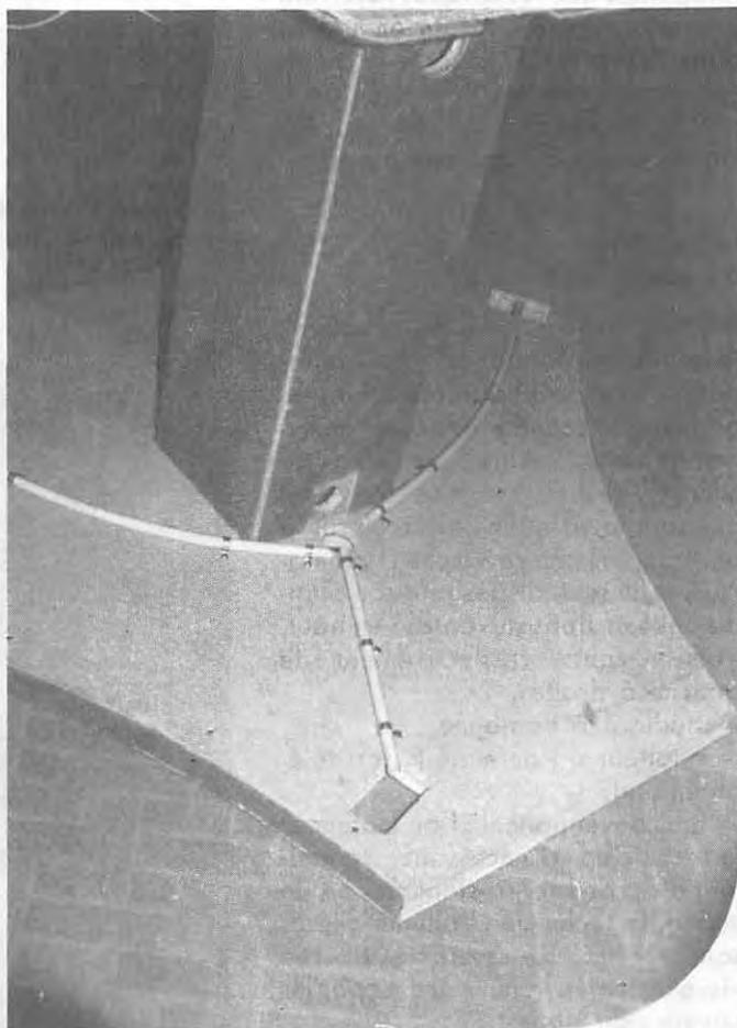
réussi à perdre ainsi une cassette, importante évidemment, en cours d'émission... ). Le passage des câbles pourrait se faire directement depuis le dessous du plancher, à condition d'avoir prévu, à sa construction, les aménagements nécessaires tels que tube de gros diamètre ou caniveau aboutissant au trou de fixation de la colonne des micros.
