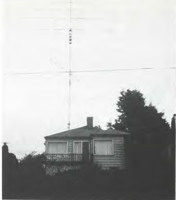
Les antennes de la station K7RI des USA (Seattle) - 4 él à 40m - 5 él à 20m - 5 él à 15m et enfin 5 él à 10m !!
