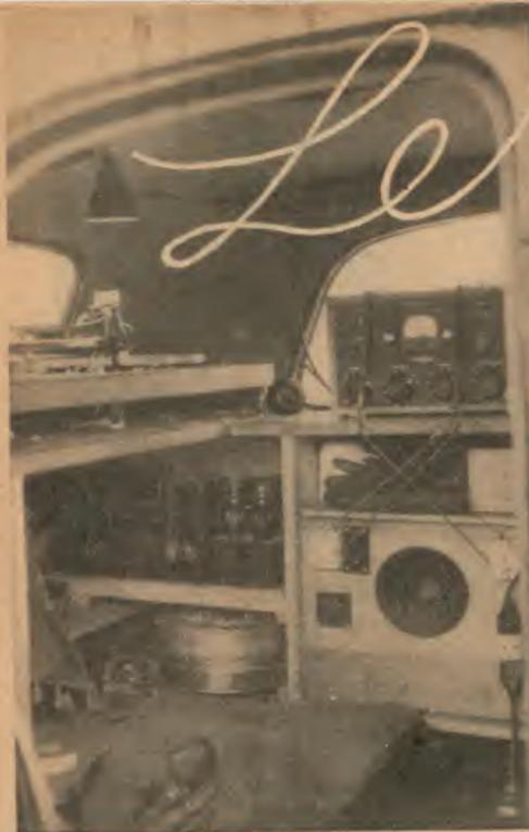
L'appareillage d'enregistrement installé aux places arrière de la voiture. On remarque, à gauche, le tourne-disque surmonté des graveurs.
