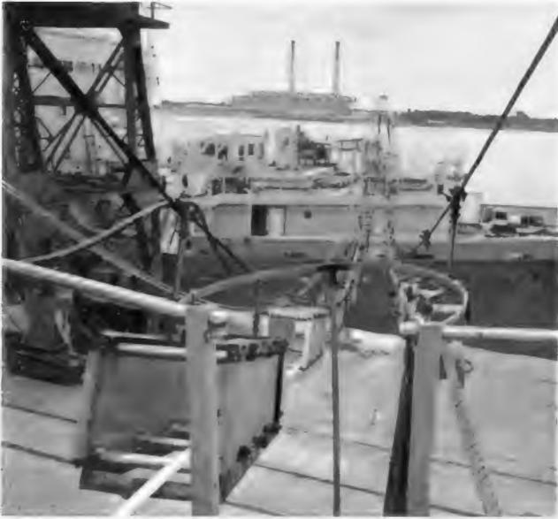
Bild 4. Das fertige, in der STC-Fabrik Southampton in Seewassertanks gelagerte Tiefseekabel (links unten) wird direkt an Bord des Kabellegers verladen
