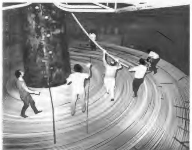
Bild 5. Das Tiefseekabel läuft in den Tank des Kabelschiffes ein – die Verstärker liegen derweilen an Deck. Pro Stunde können drei nautische Meilen übernommen werden
