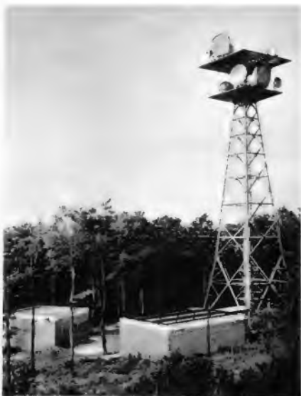
Bild 9. Stahlturm mit Betriebs- und Maschinengebäude bei einer Richtfunkstelle mit Parabol- und Muschelantennen (Foto: OPD Frankfurt/M.)
