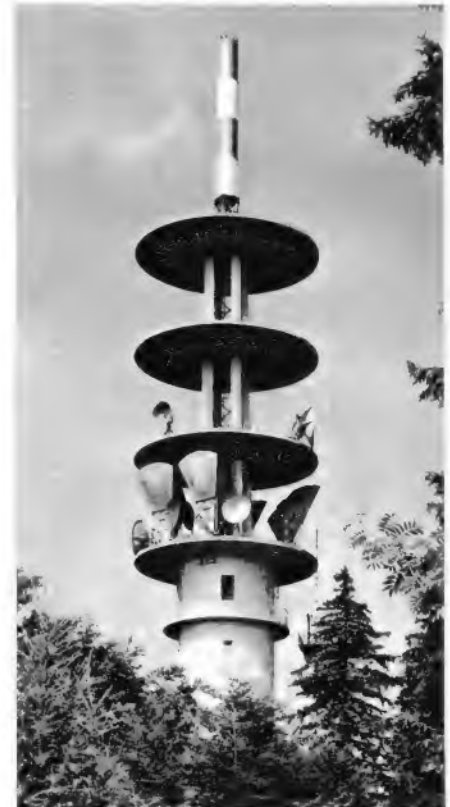
Bild 8. Fernmeldeturm bei der Richtfunkstelle Heidelberg mit Fernsehsender, Parabol- und Hornparabolantennen sowie Fernsehsendeantennen im Kunststoffzylinder (Foto: OPD Karlsruhe)
