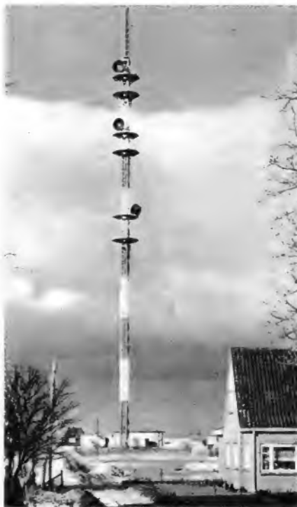
Bild 10. Abgespannter Mast mit Betriebs- und Maschinengebäude bei einer Richtfunkstelle mit Fernsehsender, Parabol- und Muschelantennen und Fernseh-Sendeantenne (Foto: OPD Kiel)
