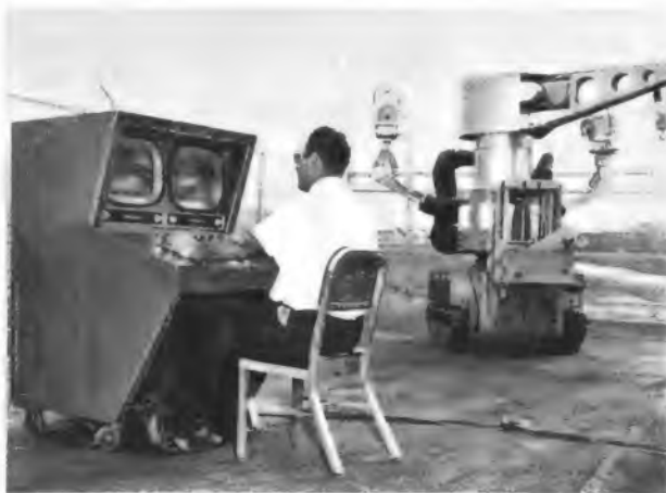
Gehorsam reagiert Mobot auf die Fernsteuerbefehle, die vom Bedienungspult kommen
