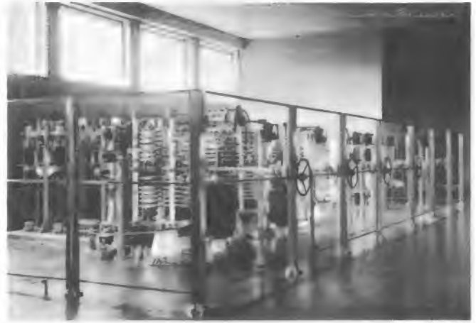
Bild 5. 100-kW-„Umbausender“ von Telefunken, im Oktober 1939 als Sender Nr. 15 ebenfalls in Berlin-Tegel errichtet
