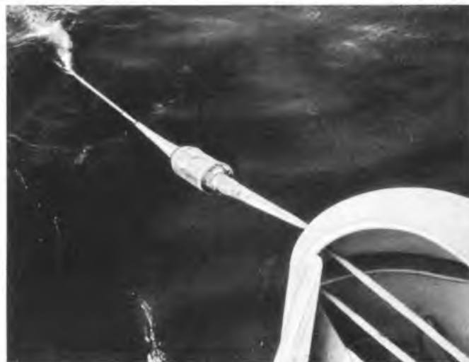
ICECAN Verstärker während der Legung
