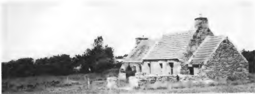
Bild 4. Ein bretonisches Bauernhaus aus Granitsteinen befindet sich in der Nähe des Radoms
