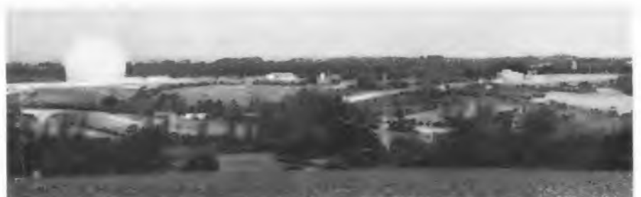
Bild 3. Die Lage der Station in einer Bodensenke schützt sie gegen Störungen durch irdische Richtfunklinien, rechts liegen die Stationsgebäude und links der große Plastikdom
