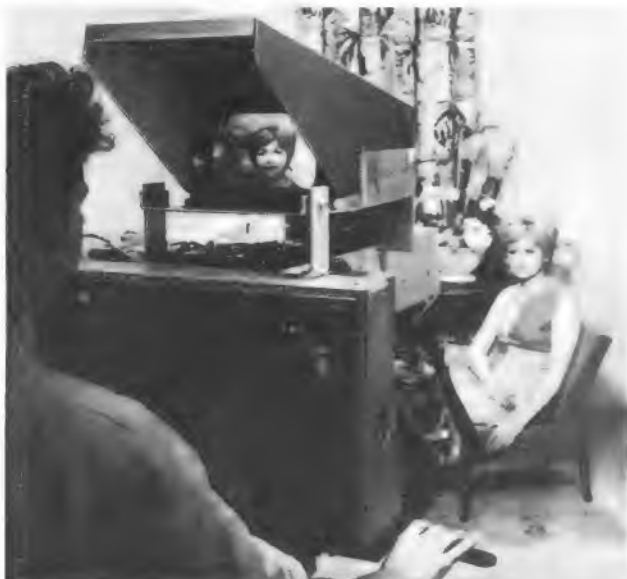
Versuchs-Farbfernsehkamera von Marconi mit drei 4 1/2-Zoll-Orthikon-Bildaufnahmeröhren
