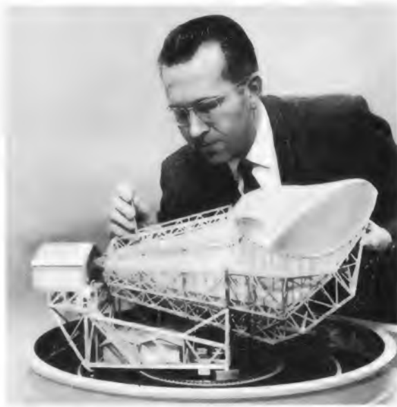
Modell einer der riesigen Hornparabolantennen, wie sie nach Unterlagen der Bell Telephone Laboratories von der Deutschen Bundespost in der Raistingener Wanne am Ammersee aufgestellt werden. Die Hornantenne ist 53 m lang und läuft auf zwei Schienenkreisen. (Die Bundespost will versuchen, mit geringeren Abmessungen auszukommen)
