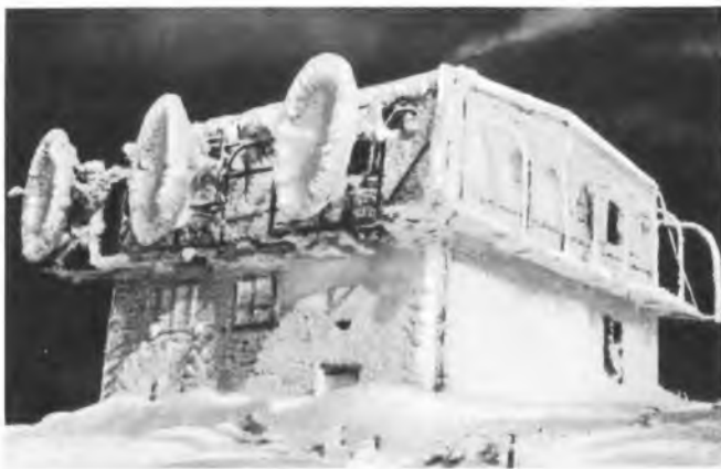
Einen nicht alltäglichen Anblick bietet diese im Eis erstarrete Relaisstation des österreichischen Richtfunknetzes, die in 2100 m Höhe auf der Koralpe an der Grenze von Steiermark und Kärnten ihren Platz hat (Telefunken-Bild)
