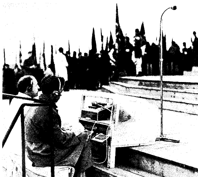
Bild 2. Transportables Regiepult zum Einpegeln der Altarmikrofone, bestückt mit zwei 35-W-SQ-Verstärkern und mit einem mit Transistoren bestückten Mikrophon-Schaltpult
