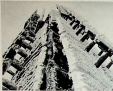
Die Antennen auf der Mastspitze im Winter — ehe die Schutzhaube aufgebracht wurde (Foto: Rohde & Schwarz)
