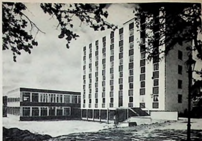
Bild 1. Gesamtansicht der Bundesfachlehranstalt in Oldenburg. Links Lehr-, rechts Wohntrakt
