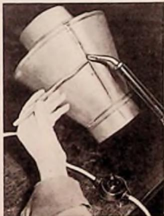
zum Signieren von Holz, Pappe, Leder oder Kunststoffen, oder mit einem Einsatz zum Schneiden und gleichzeitigen Säumen von Kunststoffen, Mipalam und PVC-Material versehen werden. Das Bild zeigt den Kolben mit schwerem Kupfer-einsatz beim Lötten einer Zinkabdeckung, eine Arbeit wie sie z. B. auch bei Antennen-Anlagen vorkommen kann. Heizkörper und Löteneinsatz sind leicht auszuwechseln, so daß sich dadurch eine recht vielseitige Anwendbarkeit ergibt (Inco, F. W. Bäumler, Ahlen/Westf.).
