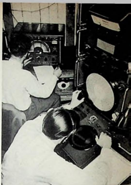
Bild 1. Bedienungsplatz des neuen Kurzzeit-Peilers von Telefunken auf dem Versuchsfeld bei Ulm
