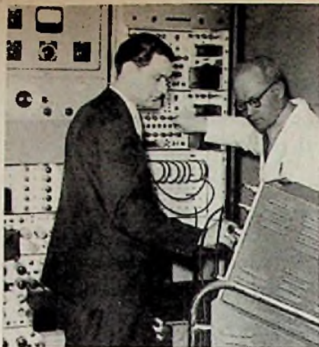
Bild 1. Die beiden deutschen Techniker Walter Lucht und Karl Bramonis beim Einpegeln des neuen Band-IV-Senders Ramstein-Landstuhl der US-Airforce
