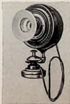
Bild 2. Lautsprechendes Telefon mit Kurztrichter von Graham aus dem Jahre 1893
