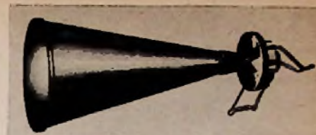
Bild 3. Telefonkapseln mit aufgesetzten Trichtern wurden in den Anfangsjahren des Rundfunks als Lautsprecher verwendet
