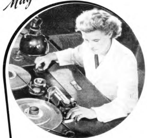
Auf die Sorgfalt, mit der das Magnetophonband BASF geprüft wird, kommt es an. — Sicherer Blick, Fingerspitzengefühl und eine automatisch arbeitende Fotozelleneinrichtung, die auf kleinste Fehler genauestens reagiert, sind zuverlässige Bürgen für die hohe Fehlerfreiheit und große Gleichmäßigkeit der Typen L extra und LGH.
