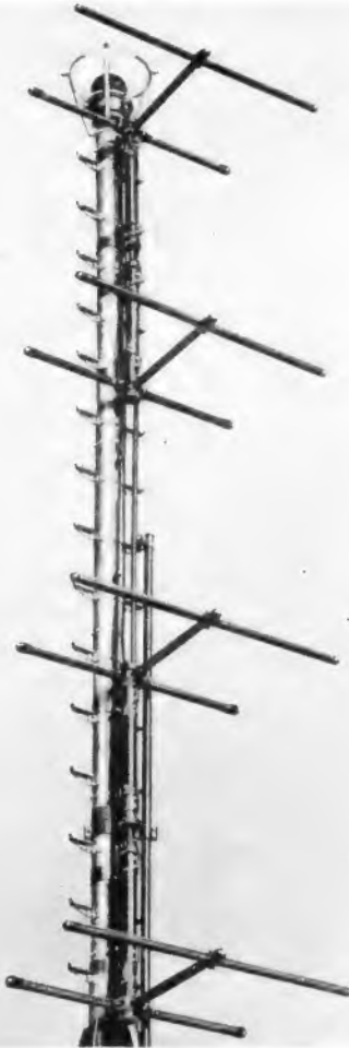
Bild 5. Ansicht der oberen Hälfte der Richtstrahlantenne mit Speiseleitung, Symmetrierung und Flugzeugwarnlampe mit Blitzschutz (Fotos: Werkaufnahmen Rohde & Schwarz)
