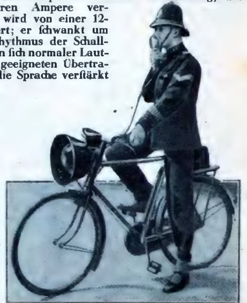
Englischer Polizist mit einer röhrenlosen Kommandoanlage. (Auslandsbild)
