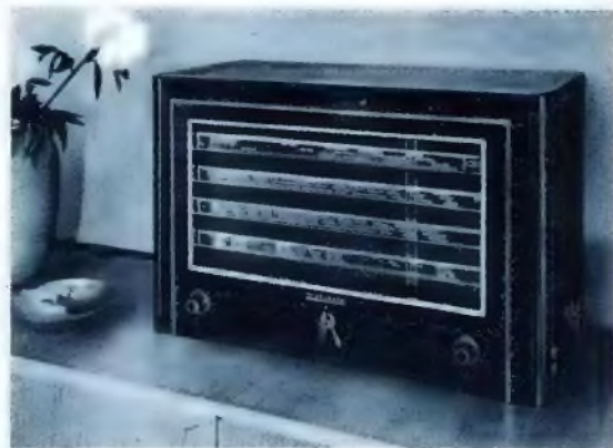
Der Empfänger mit der größten Skala: In Form von vier Glasstreifen mit eingezähten Namen nimmt sie die ganze Fläche der Lautsprecheröffnung in Anspruch (Telefunken-Spitzen-tuper 898).
