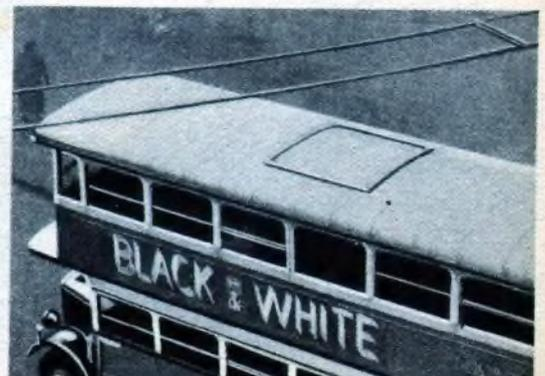
Ein Omnibus während der Durchfahrt unter der Empfangseinrichtung, einer rechteckigen Spule.
