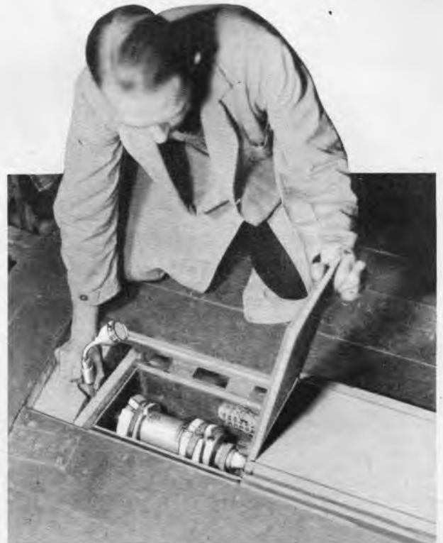
Aus dem Bühnenboden ragt nur die kleine Mikrofonkapfel hervor. Alles andere, wie Verstärker, Befestigung usw., liegt wohl geborgen unterhalb der Bühne. Werkaufnahme Telefunken.
