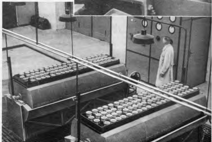
Unten: 3. Die Elektroden werden „formiert“, d. h. der Kern durch starke und hoch gespannte Ströme einer Oxydation unterworfen, die mit Hilfe von Meßinstrumenten überwacht wird. Da sich sehr viel Wärme bildet, ist eine besondere Wasserkühlung erforderlich.
