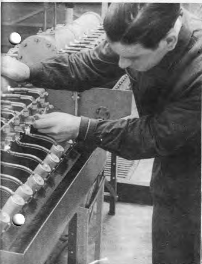
Oben: 5. Von größter Bedeutung für die einwandfreie Arbeitsweise des Kondensators ist die Zusammensetzung des Elektrolyten. Sie wird von den Firmen streng geheim gehalten. Unser Bild zeigt die Füllung der Kondensatoren, die reihenweise angeordnet sind, mit dem dickflüssigen Elektrolyten. Am Füllstand wird genau darüber gewacht, daß jeder Kondensator die richtige Menge eingefüllt bekommt. Glashähne in den einzelnen Fülleitungen erlauben eine sorgfältige Dosierung der notwendigen Menge.
